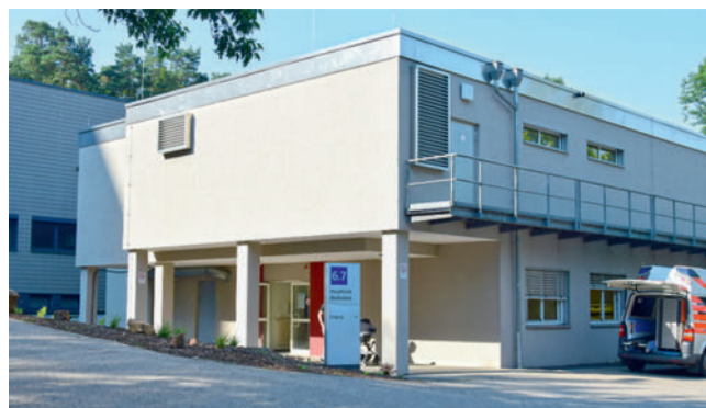
► Abb. 1 Teilneubau der dermatologischen Hochschulambulanz und des neuen OP-Trakts in Erweiterung der Kombiklinik im Gebäude 6 auf dem Campus Homburg.
