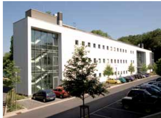
Forschungs- und Laborgebäude 61.4
